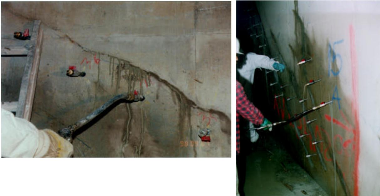
**Abb. 4:** *Injektion mit Zementsuspension*
