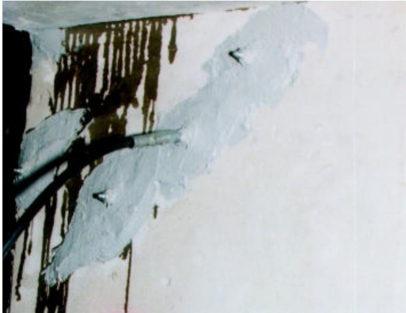
**Abb. 3:** *Links: Klebepacker mit Verdämmung während der Injektion*
